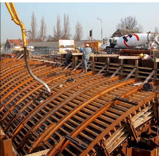
• Pompen/persen van mortel in tunneldek.
