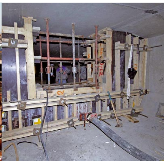
• Pompen/persen van mortel in wand.
